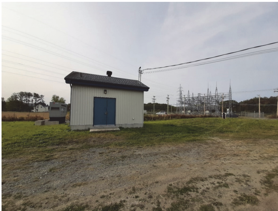
Photo 4 : Aperçu de la station de pompage des puits P-1 et P-2 – 2020-09-22
