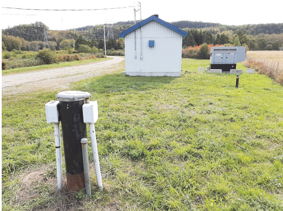
Photo 1 : Aperçu du puits P-1 - 2020-09-22
