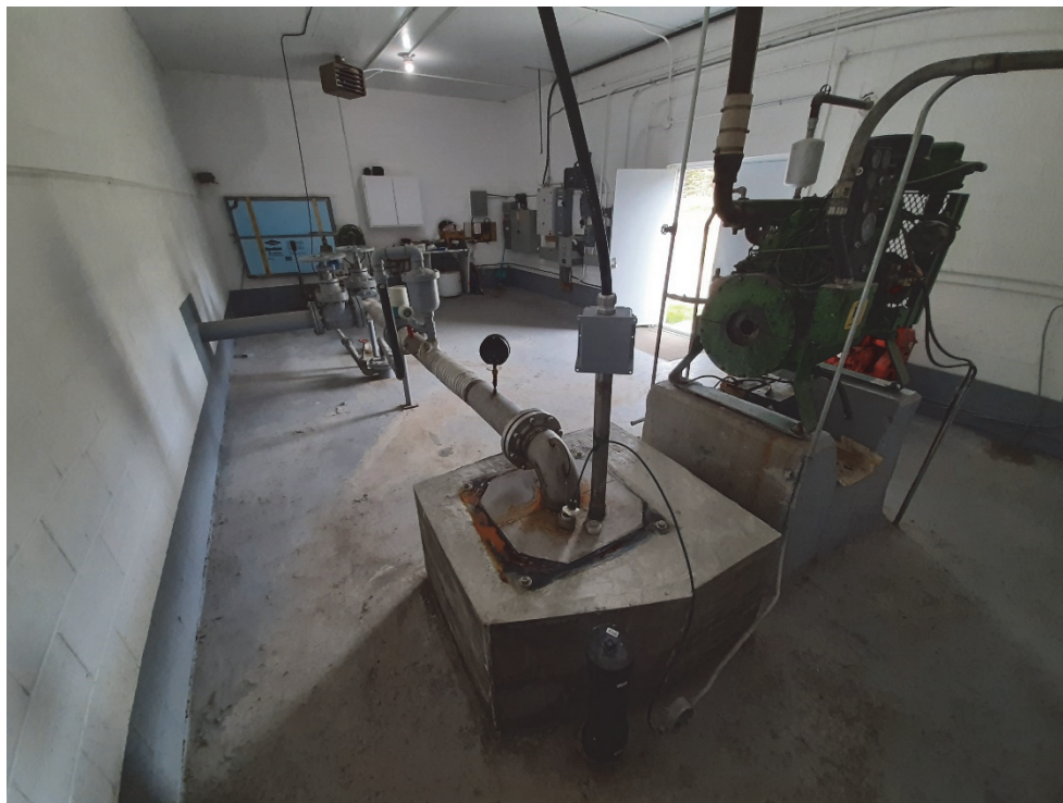
Photo 3 : Aperçu du puits P-3 - 2020-09-22
