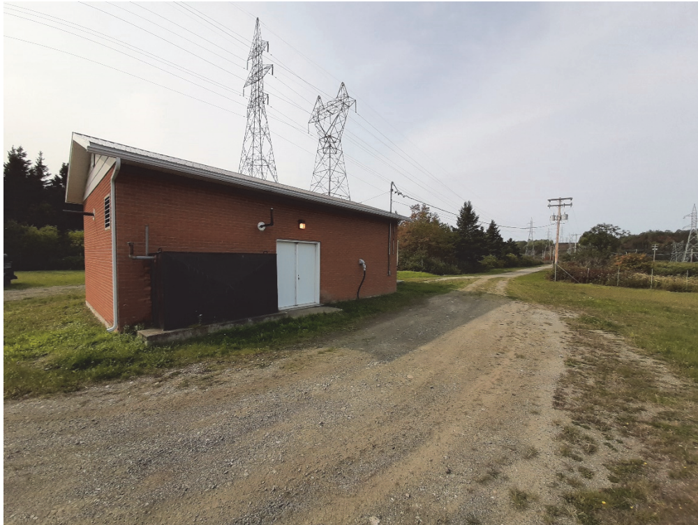
Photo 5 : Aperçu de la station de pompage du puits P-3 – 2020-09-22
