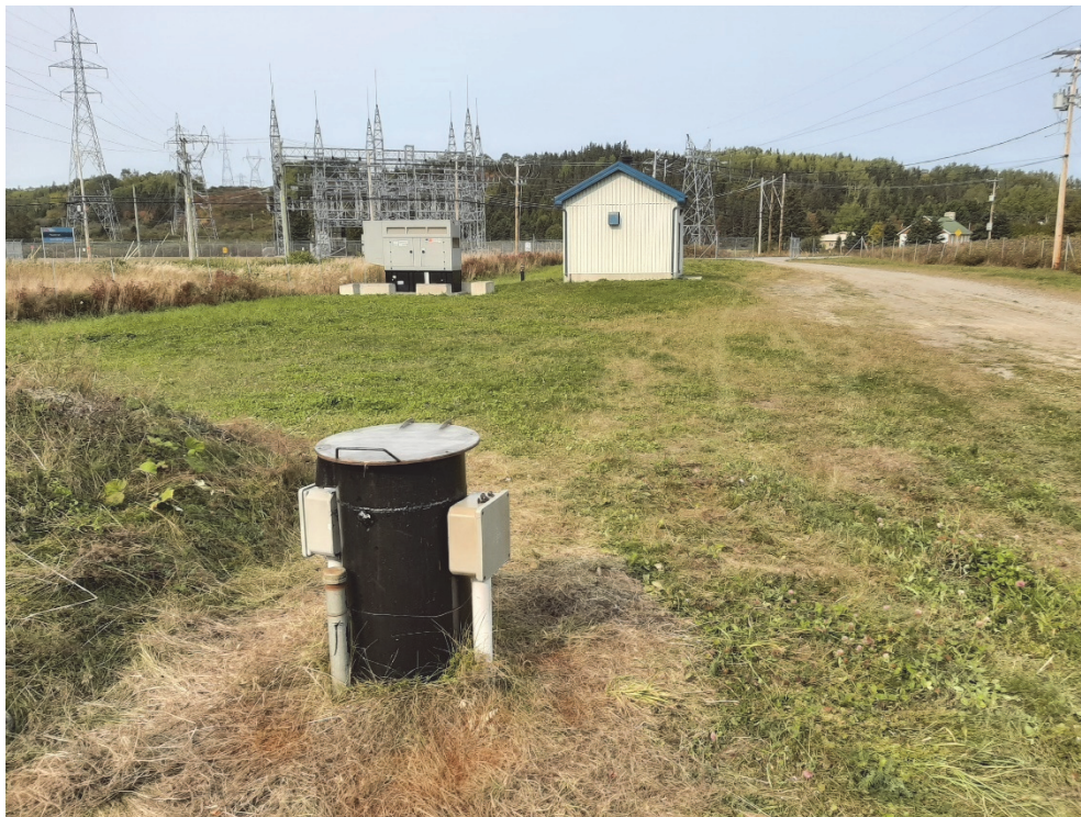
Photo 2 : Aperçu du puits P-2 - 2020-09-22
